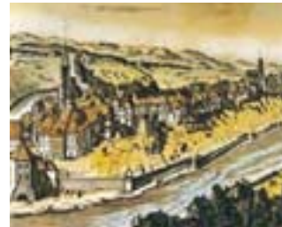
Abb. 19 Stadtansicht 1760, die 1639 – 1650 erbaute Längmur
