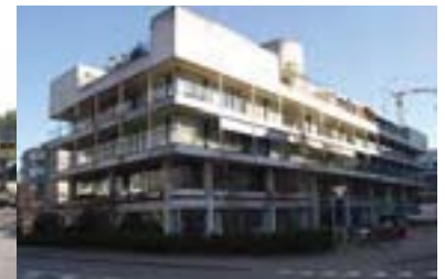
Verwaltungsbau Sulgeneckstrasse aus den 70er Jahren
