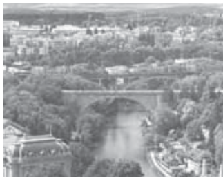
Abb. 31 Lorraine-, Eisenbahnbrücke nach 1989
